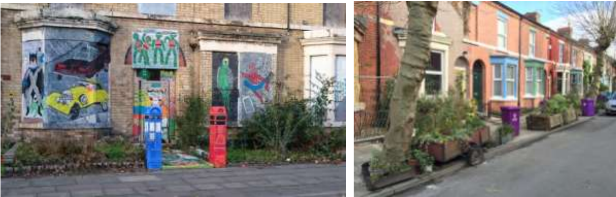
Photos 3-4: CLT Granby Four Streets avant et après rénovation.
